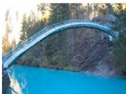
Rohrbogen über Plessur
